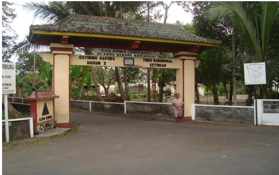
Pintu gerbang utama masuk Desa Wisata Ketingan dengan ditandai bangunan gapura yang megah
